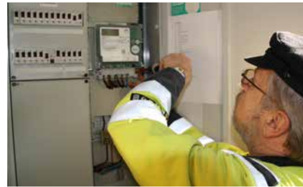
Einbau einer modernen Messeinrichtung
